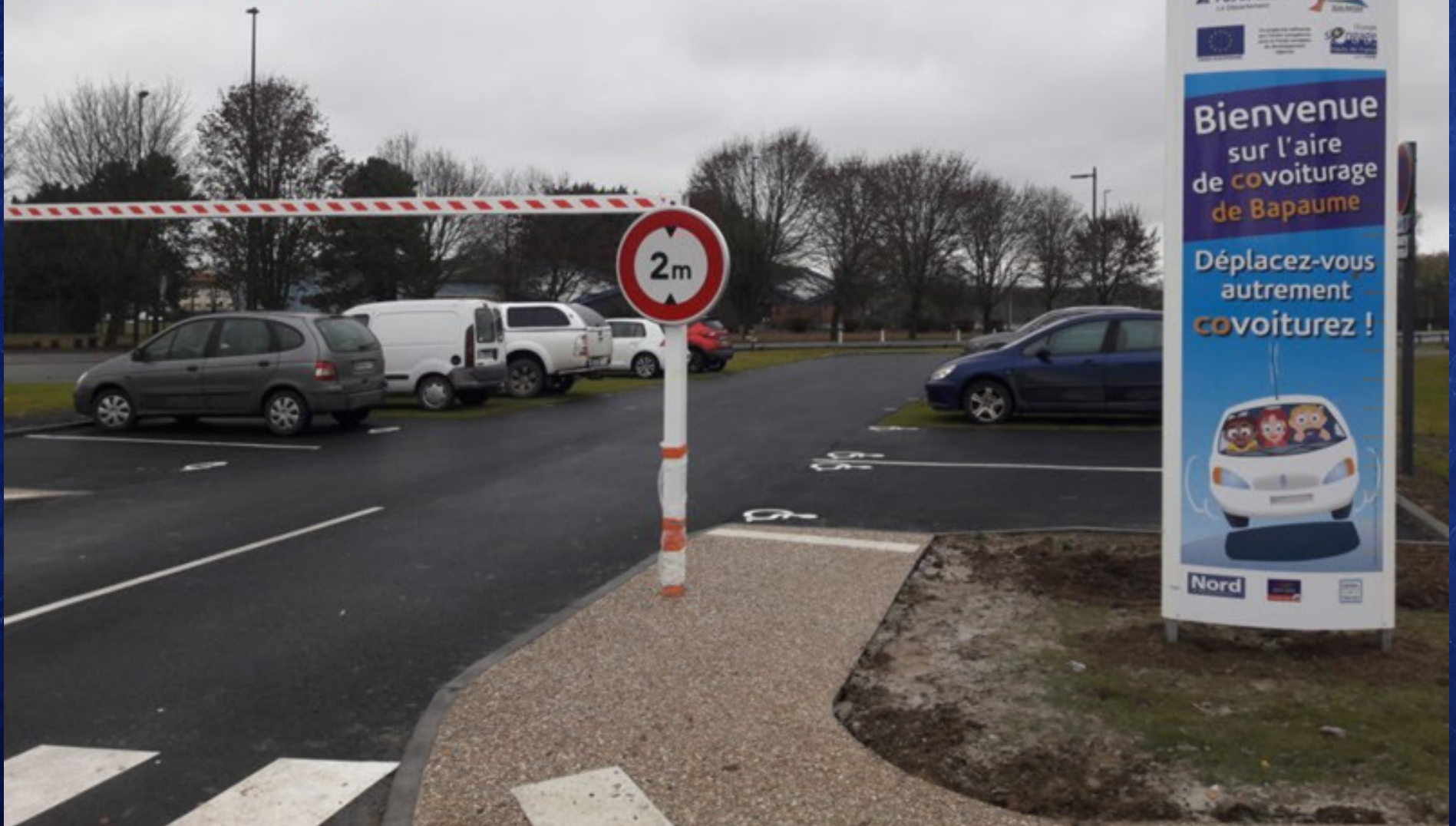
L'aménagement d'une aire de covoiturage à Bapaume cofinancée par la communauté de communes Sud-Artois, le département du Pas-de-Calais, l'État français et l'Union Européenne (FEDER)
