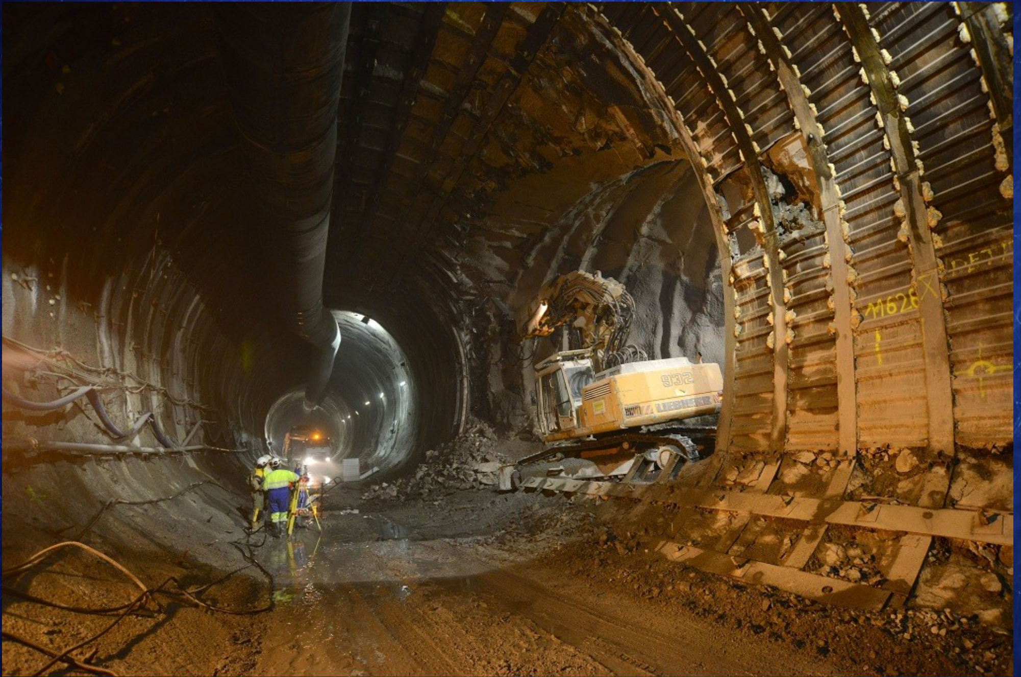
Creusement du tunnel de la liaison ferroviaire Lyon-Turin
