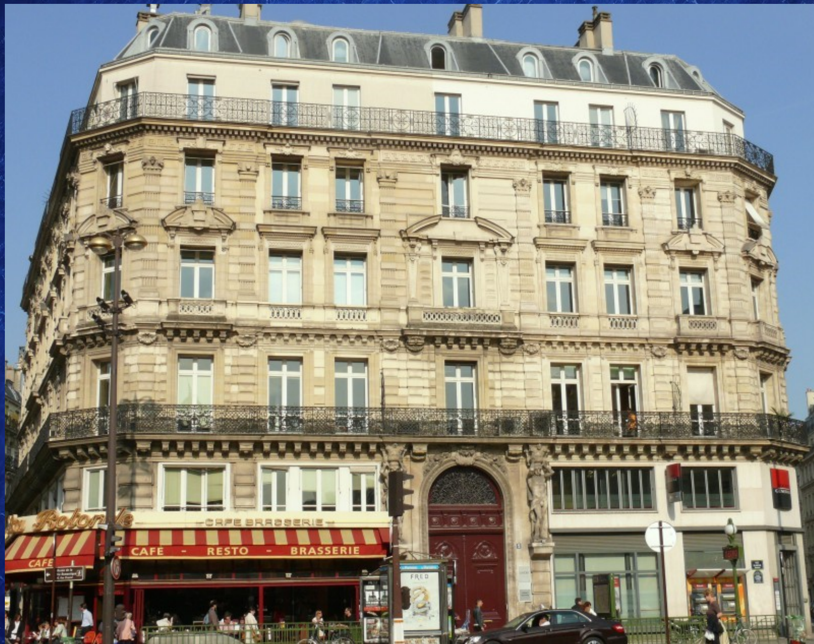
IMMEUBLE HAUSSMANNIEN À PARIS
