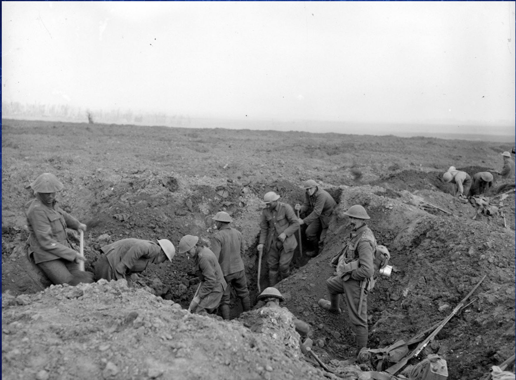
Troupes néo-zélandaises creusant une tranchée sur le front de la Somme, 1916
