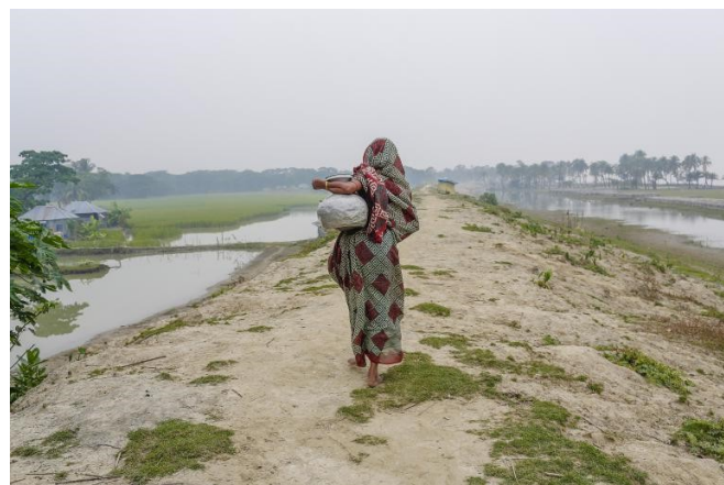
Digue en terre sur l'île de Bhola pour contenir la rivière Meghna et la baie du Bengale
